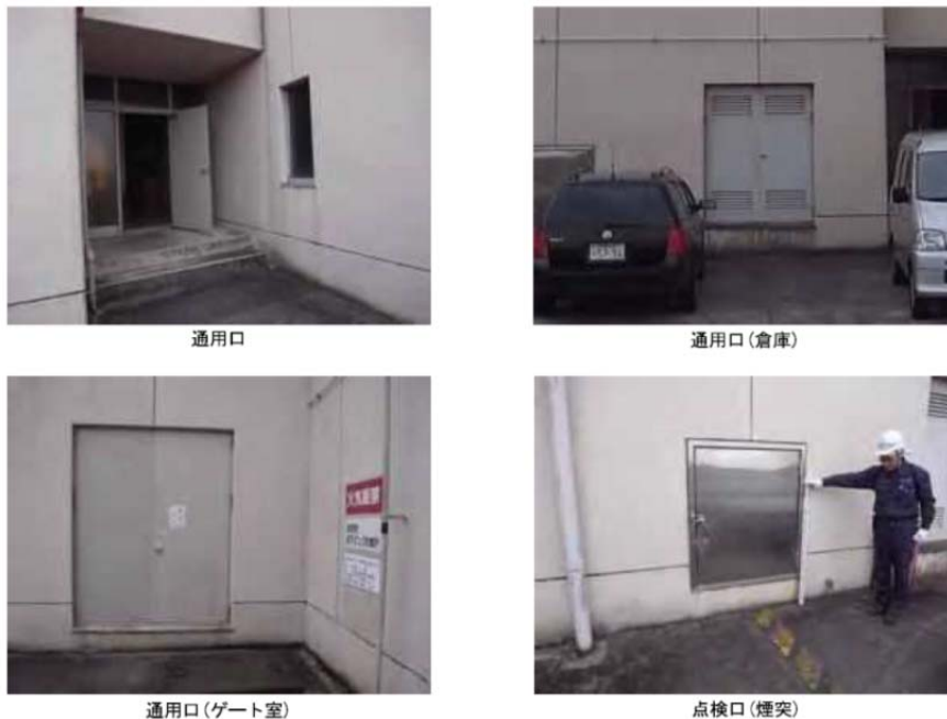
図 3-2-10. 守山ポンプ場における建屋開口等の調査状況
