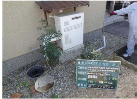
図 3-2-17. 不明水発生箇所の調査状況
