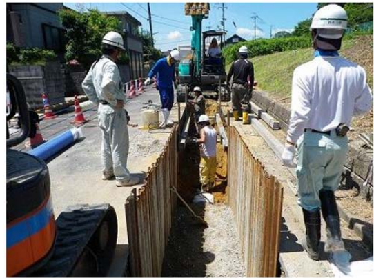
図 3-1-9. 下水管の布設状況
