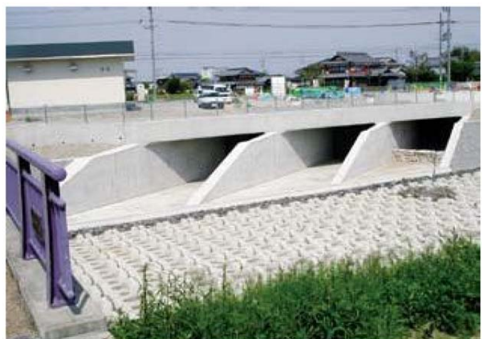
図 3-2-9. 守山栗東雨水幹線（新守山川放流部）
