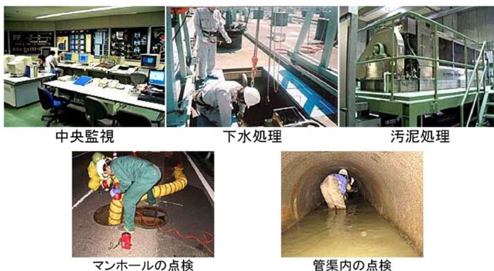
図 3-2-44. 下水道施設の管理状況
