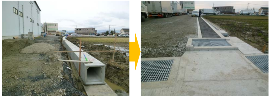
図 3-2-7. 守山市雨水渠の整備（施工中、完了）
